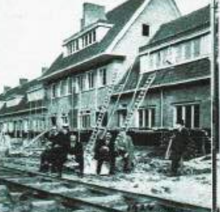
Fertigstellen: Versteeg, de Linaal, Sibet, Lagerste, van Marthogen en van Binn. Met de tram (in hoofd) wordt bouwwerkzaam aangevoerd.
